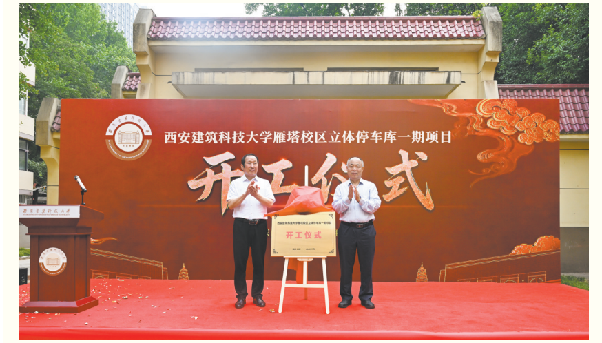
7月16日上午,我校雁塔校区立体停车场一期项目开工仪式在南院举行。立体停车场项目是学校解决师生急难愁盼的民生工程,也是建设平安、智慧校园的重要举措。工作专班将全力以赴确保按期保质交付,不断增强师生获得感、幸福感、安全感。
